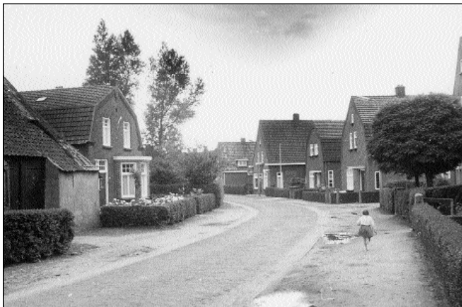
Nog juist zichtbaar 'ons' schuurdeur. Daarachter het huis van Bert 'de Jonker' gebouwd in 1929. De foto is van 1961.
