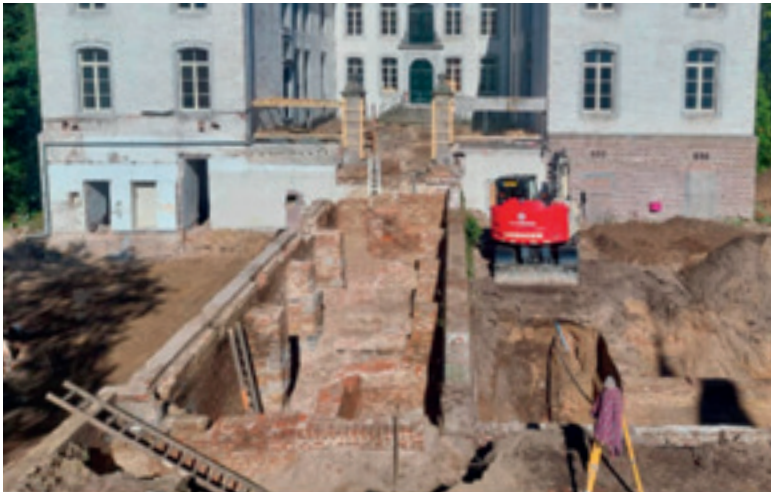
De brug over de binnengracht, zoals aangetroffen in oktober 2024. (foto Econsultancy)
