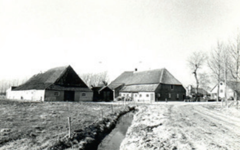
Het goed Ten Broek of de Armenhoeft in de Kromstraat, gezien vanaf de Oude Helmondseweg met links op de foto de verdwenen schuur.
