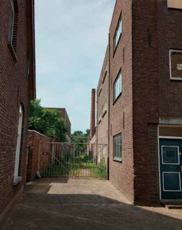
Tussen de gebouwen van de textielfabriek loopt nog de oude steeg van vóór 1713 vanaf de Schoolstraat.
